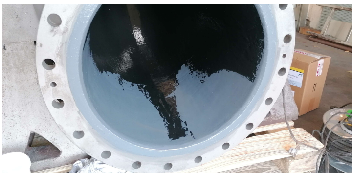
Aplikacja kompozytu ARC 858 na ARC 855
