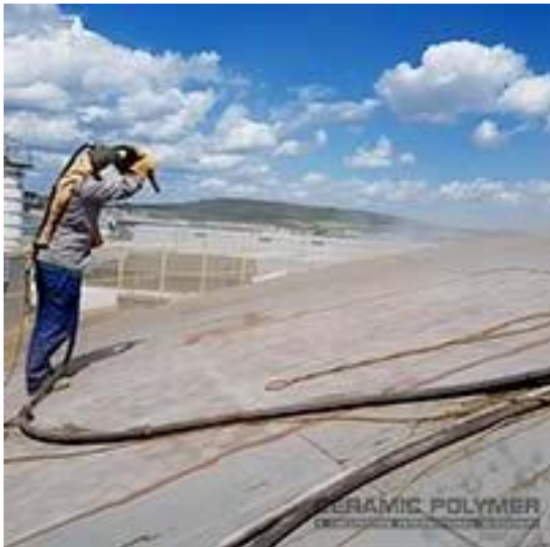
Powierzchnia dachu została przygotowana przez piaskowanie do stopnia czystości Sa2,5.
