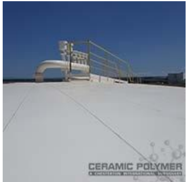
Dach z nałożonym podkładem i powłoką nawierzchniową
