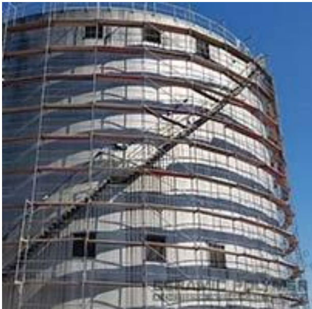
Cienką warstwę podkładu i powłoki nawierzchniowej nałożono metodą natrysku bezpowietrznego
