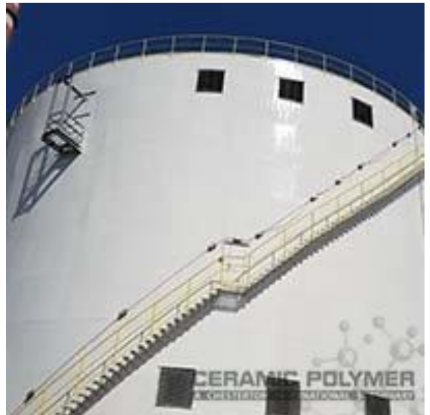
Odnowiony zbiornik; trwała ochrona przed korozyjnymi wpływami środowiska przemysłowego
