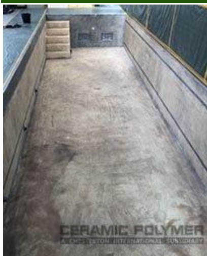
Beton gruntowany jest CP Synthofloor BETA 8016 i posypany piaskiem kwarcowym.
