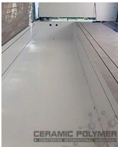
Materiał powłokowy został nałożony w nieco grubszej warstwie w celu uzyskania bardzo gładkiej powierzchni, a tym samym zwiększenia właściwości ochronnych i estetycznych.
