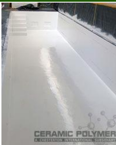
pierwsza aplikacja jasnoszarej powłoki PROGUARD CN 200, nakładana metodą natrysku bezpowietrznego
