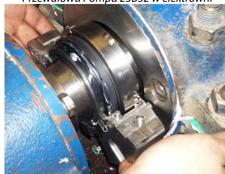
Dzielone Uszczelnienie Mechaniczne 442 Pracuje od 5 lat na 6 pompach
