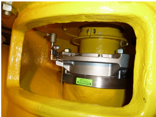
Przykład zastosowania uszczelnień dzielonych Chesterton w pompach typu D i pompach Sigma wody chłodzącej
