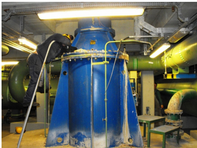
Przykład zastosowania uszczelnień dzielonych Chesterton w pompach typu D i pompach Sigma wody chłodzącej
